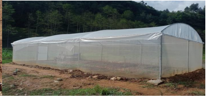
स्लिन हाउस निर्माण
